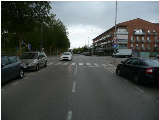
Imatge 105. Gir obert cap a carrer dels Països Catalans i pas de vianants lluny de la vorera a la que dona continuïtat.
