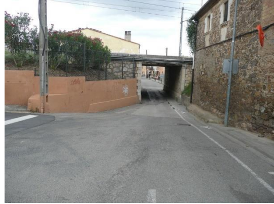
Imatge 133. Vista de la sortida de Sant Feliu amb el pas subterrani del carrer de les Paret. Vegeu la distància entre carrer i túnel.
