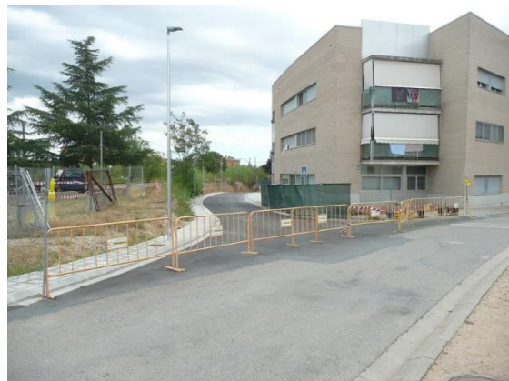
Imatge 121. El vial, en obres, junt a l'edifici residencial.
