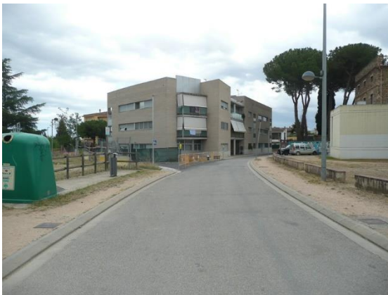
Imatge 120. Aproximació a la confluència al nou vial des de l'estació.
