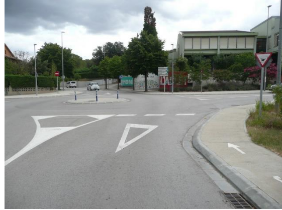
Imatge 85. Veieu el ramal de carretera de Juià i l'anella central reduïda i sols senyalitzada amb pilones.
