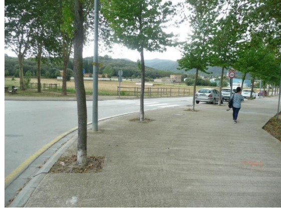
Imatge 46. Vegeu distància des de la vorera (cantonada) fins al pas del ramal adjacent. Carrer dels Països Catalans.
