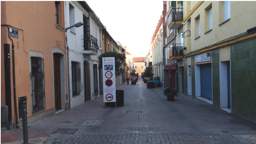
Imatge 1 Exemple de configuració de vies en plataforma única amb ús de mobiliari. Municipi de Premià de Mar.
