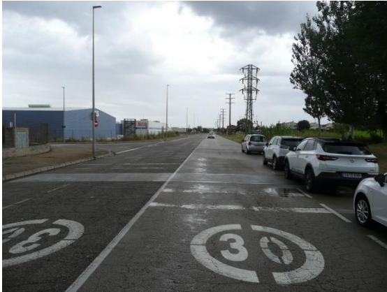
Imatge 136. Llom reductor entre carrer de Molins i del Torrent d'Orriols.
