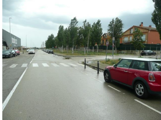
Imatge 60. Pas de vianants a carrer de les Parets. Piloneres per protegir la visibilitat del pas.
