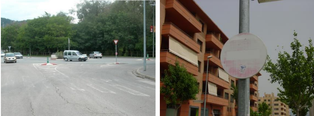
Imatge 10 Senyalització en estat deficient
